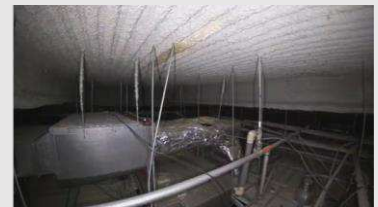
天井裏内部 (IBIS2撮影映像より抜粋)
