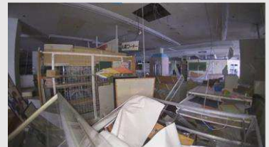
大型商業施設内部 (IBIS2撮影映像より抜粋)
