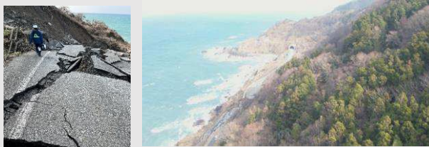
土砂崩れによる孤立地域をドローンで上空から撮影
