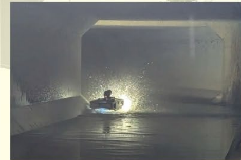
下水道管調査
