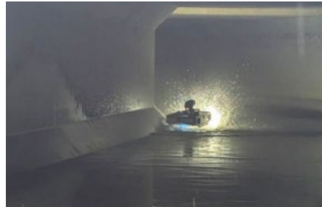
飛行中の様子 (雨水管内)
