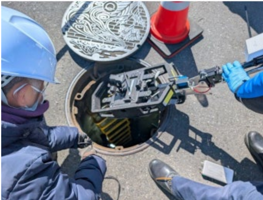
下水道管点検の様子
