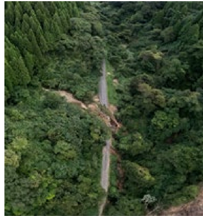
土砂により道路が寸断されている様子 (能登半島豪雨)
